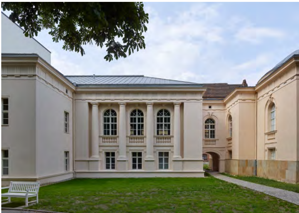
04 | Nordostfassade nach der Sanierung 2019; Links die Erweiterung »Wolfbau« von 1936
