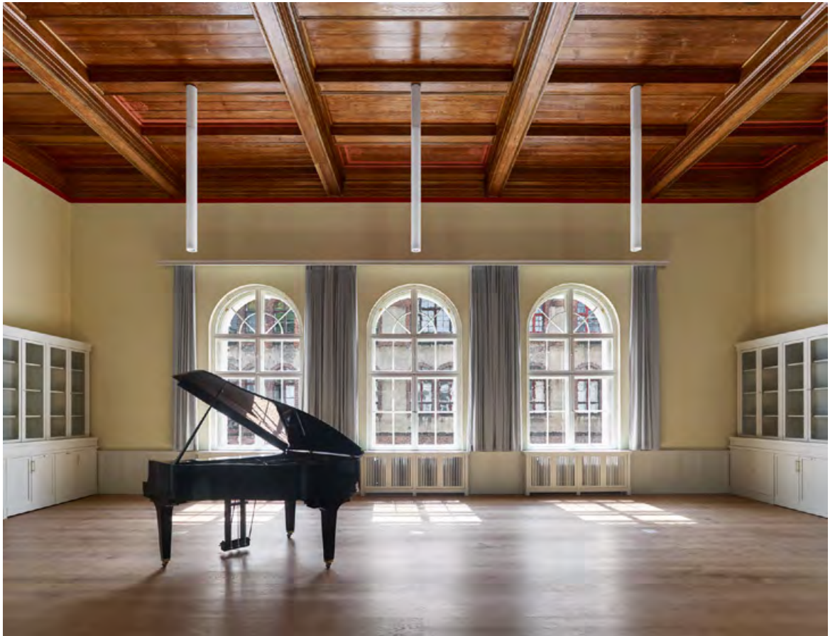
09 | Die bauzeitliche Holzkassettendecke mit wertvollen Schablonierungen wurde freigelegt und wiederhergestellt
