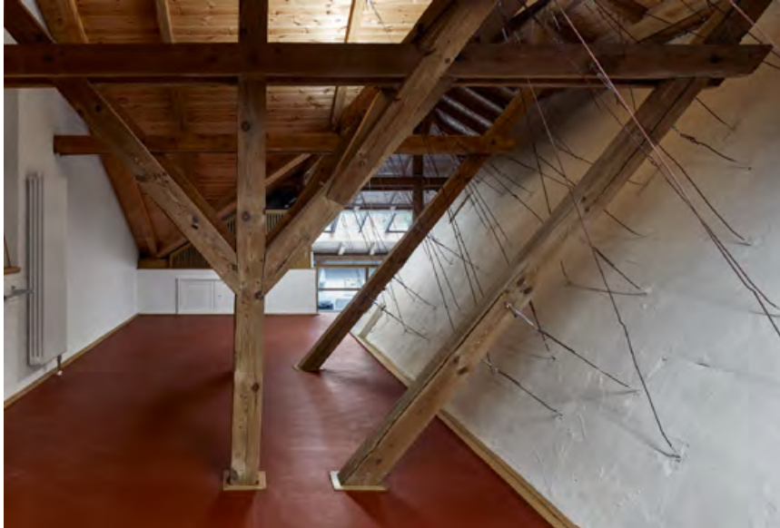
15 | Dachraum mit Rabitzabhängung
