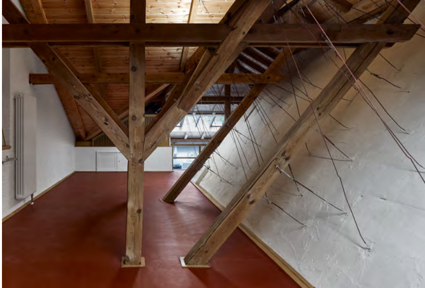
15 | Dachraum mit Rabitzabhängung
