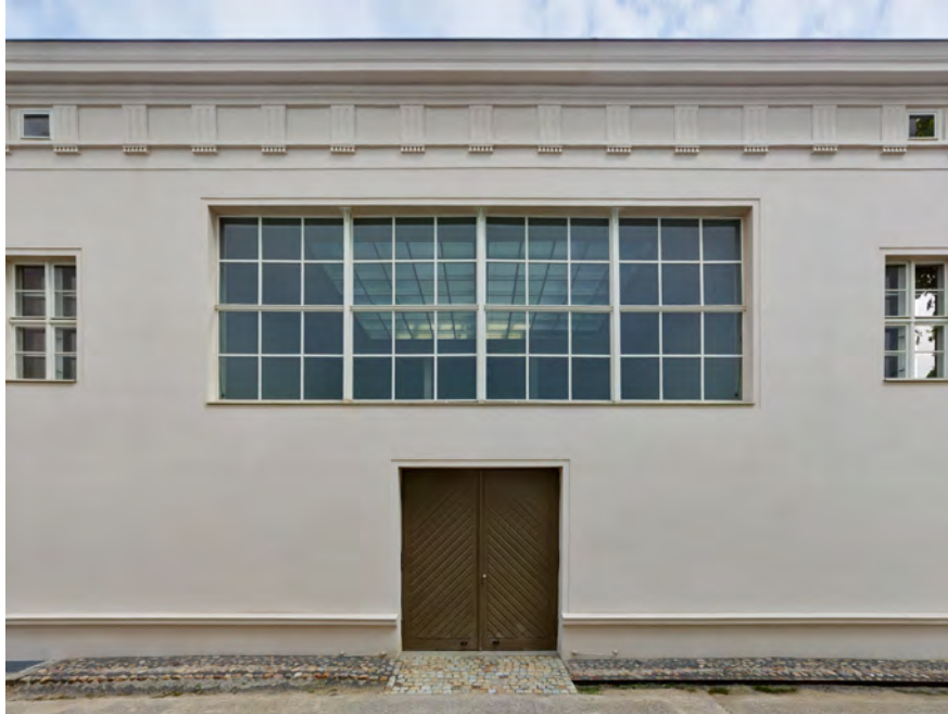
11 | Eingang der ehemaligen Schlachterhalle
