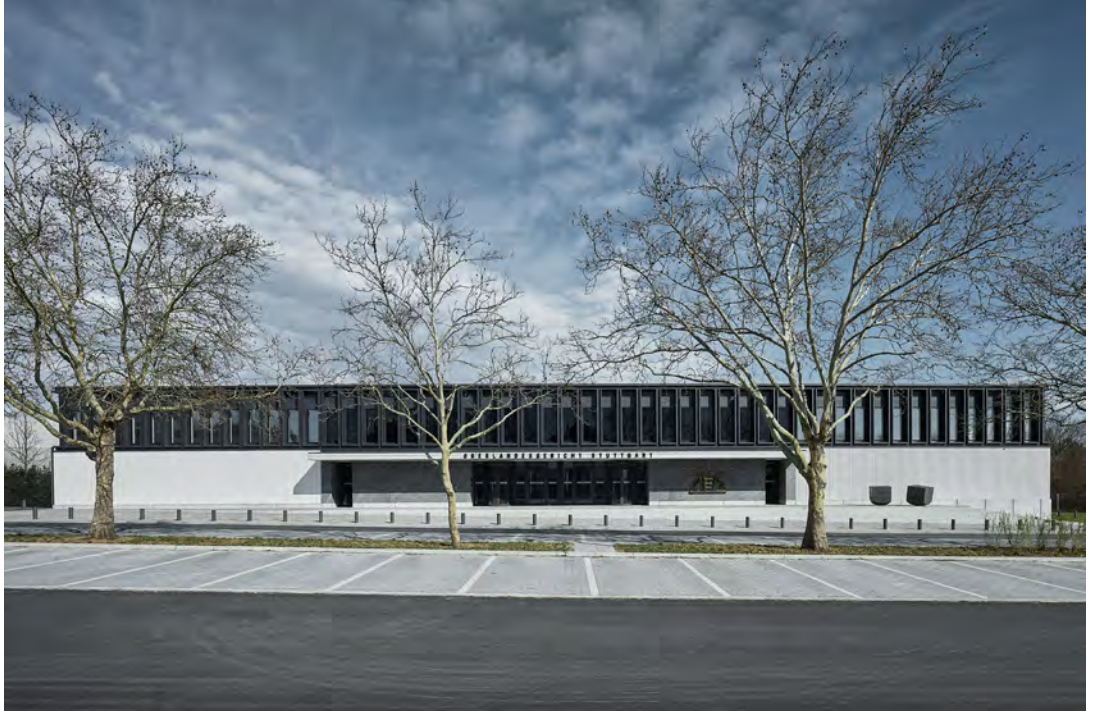
09 | Gesamtansicht von Süden
