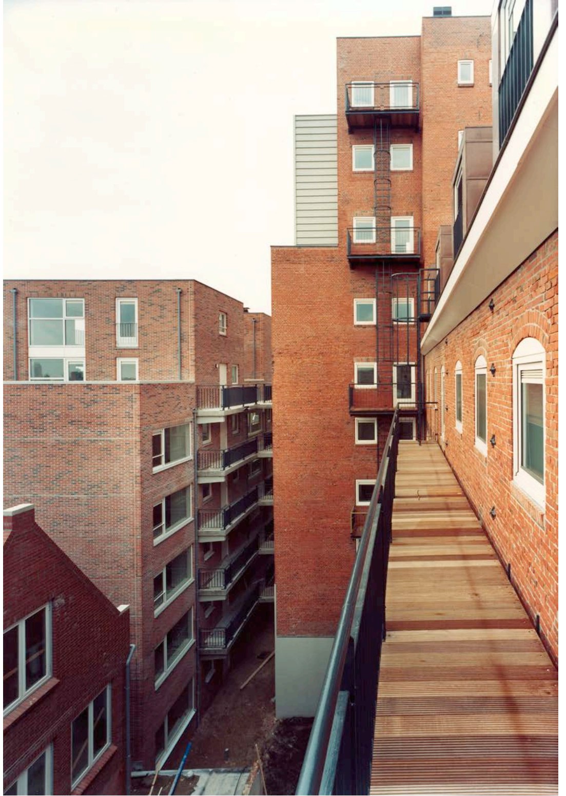
07 | Blick vom Laubengang auf den Erweiterungsbau
