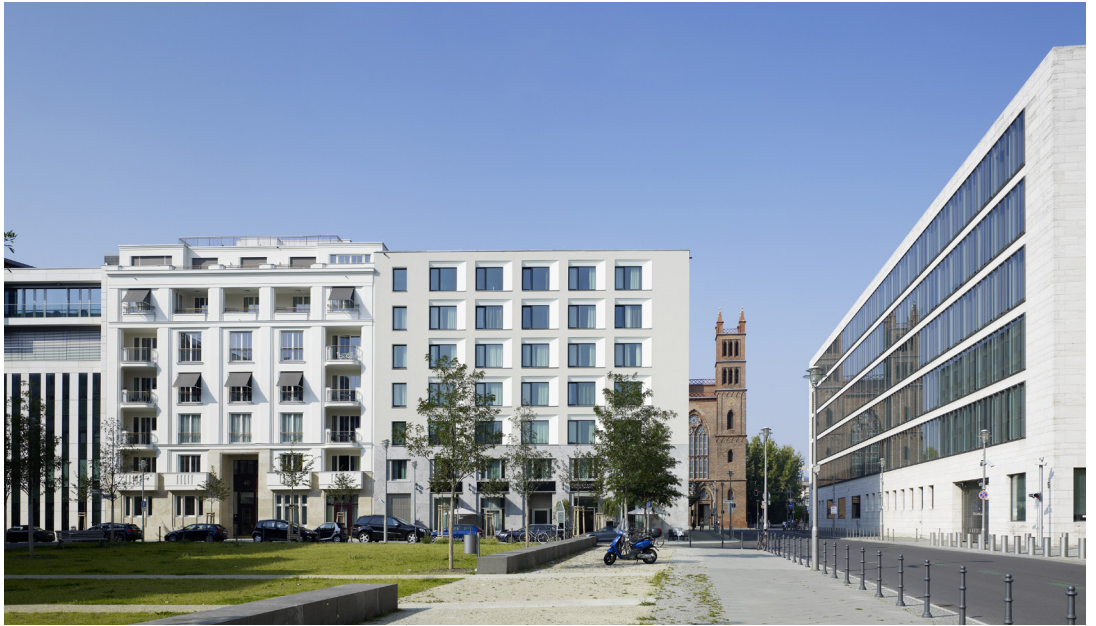
01 | Ansicht Arcotel Jägerstraße
