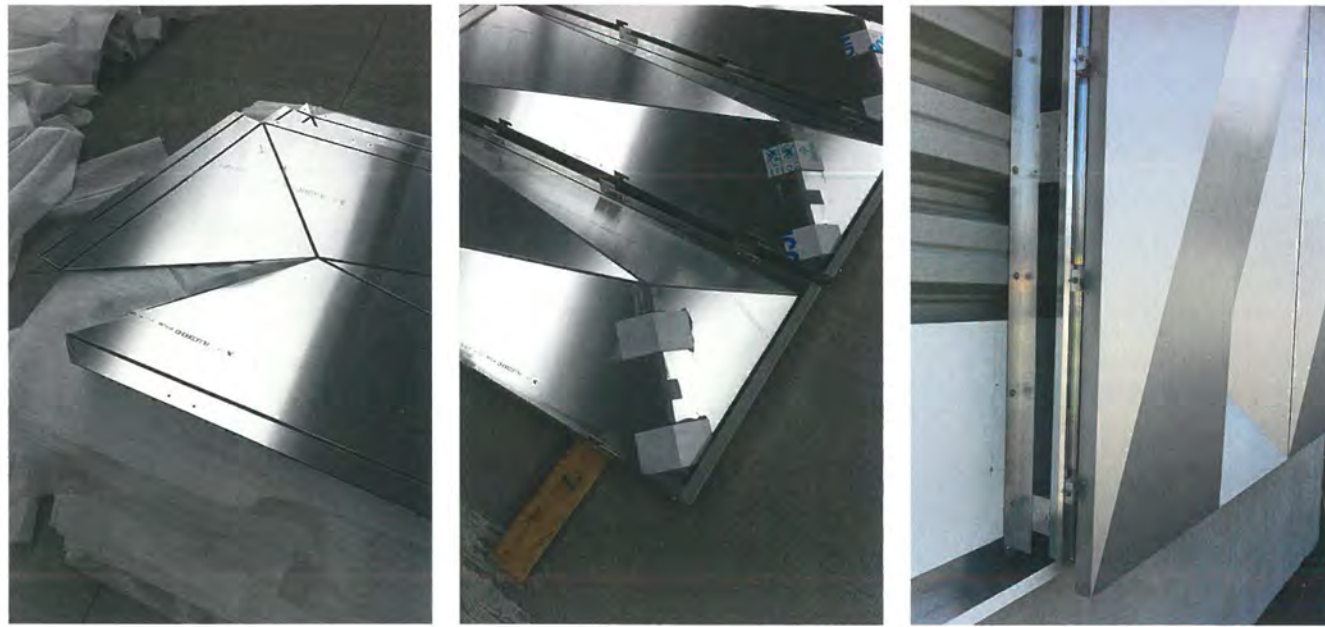
Die beschichteten Alu-Verbundplatten kamen zugeschnitten und gefräst auf die Baustelle, wo sie zu konkaven und konvexen 3D-Elementen gefaltet und verklebt wurden. Unten: die Drive-In-Halle mit „Laterne“ aus Polycarbonat
