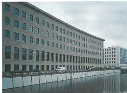
Die östliche Fassadenfront des ehemaligen Reichsbankgebäudes. Alle Fassaden aus leicht bossiertem Sandstein und das markante Dachgesims wurden saniert und gereinigt, die Fenster teilweise ersetzt.
